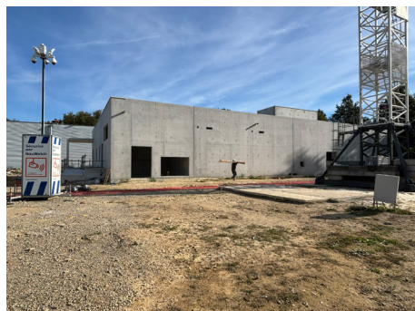
Futur datacentre du site de La Chantrerie à Nantes
